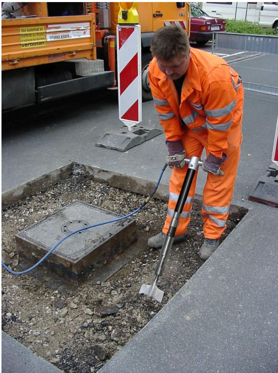
Der Vogt TurboSpaten »VTS« bricht z. B. Erdschichten leichter auf oder verdichtet mit entsprechenden Aufsätzen Schotter. (Bild: Vogt).
