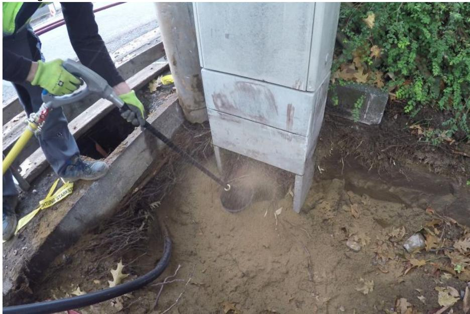
Mit der Druckluftlanze wird das Erdreich gelockert und empfindliche Leitungen schonender freigelegt (Bild: Vogt).
