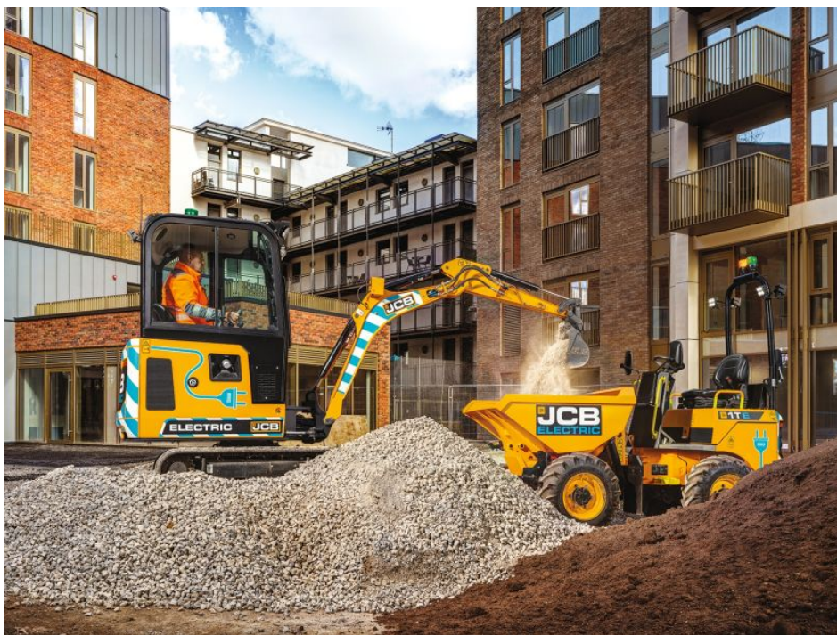
Minibagger und Dumper im Einsatz (Bild: JCB).
