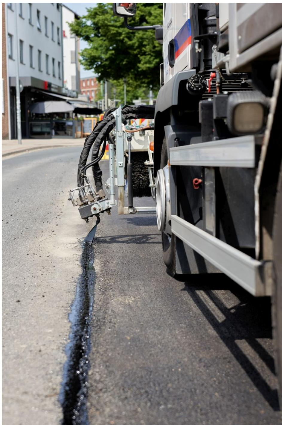
Anspritzen der Kante für einen besseren Nahtverbund der Asphaltdecken. (Bild: schäfer-technic).
