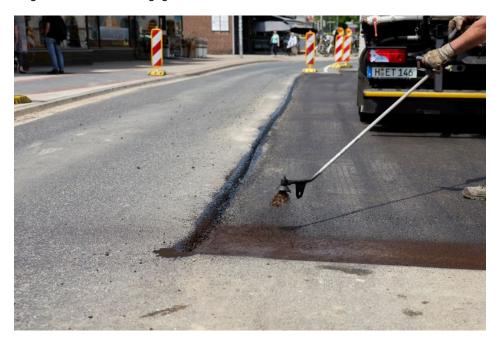
Bedarfsweise kommt die Handspritzlanze zum Einsatz. Von der 10-m-Schlauchtrommel wird nur so viel abgewickelt wie benötigt wird. Das vermeidet den Bodenkontakt und damit die Verschmutzung des Schlauches (Bild: schäfer-technic).
