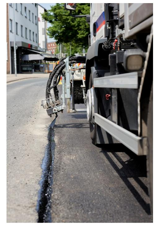
Anspritzen der Kante für einen besseren Nahtverbund der Asphaltschichten. (Bild: schäfer-technic).
