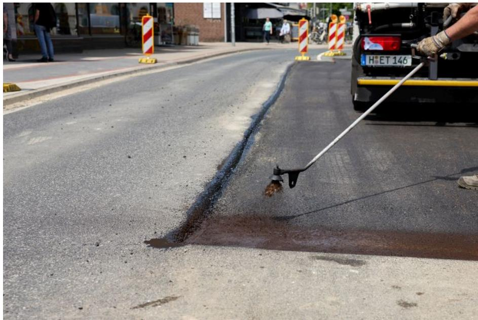
Bedarfsweise kommt die Handspritzlanze zum Einsatz. Von der 10-m-Schlauchtrommel wird nur so viel abgewickelt wie benötigt wird. Das vermeidet den Bodenkontakt und damit die Verschmutzung des Schlauches (Bild: schäfer-technic).
