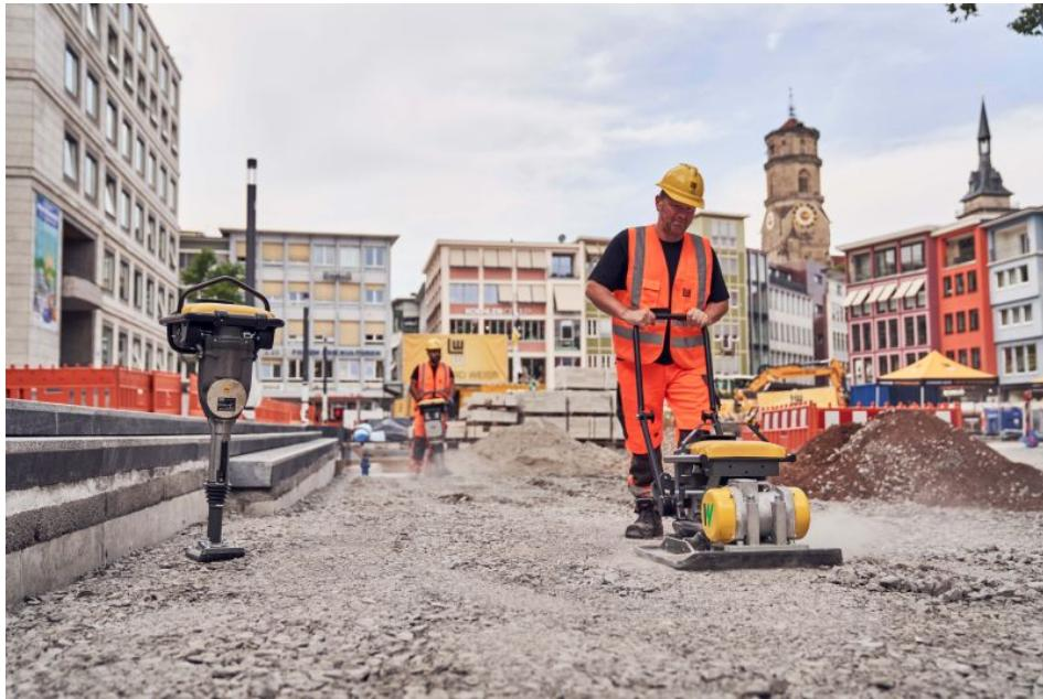
Akkustampfer sowie Akkuplatten aus der neuen »APS«-Reihe kamen in Stuttgart zum Einsatz (Bild: Wacker Neuson).
