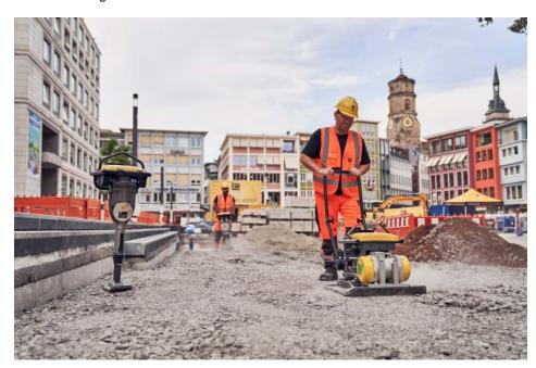
Akkustampfer sowie Akkuplatten aus der neuen »APS«-Reihe kamen in Stuttgart zum Einsatz (Bild: Wacker Neuson).
