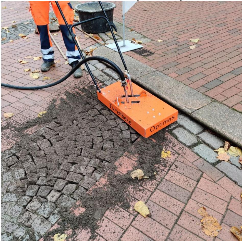
Der »Fugenbooster« reinigt Fugen tief, gleichmäßig und ohne Sand oder Steine umherzuwirbeln (Bild: Optimas).
