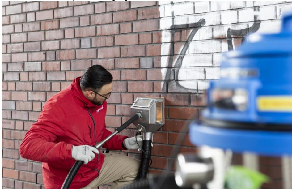
Einfache und umweltschonende Entfernung von Graffiti mit dem »Tornado« Unterdruckstrahlsystem (Bild: systeco).
