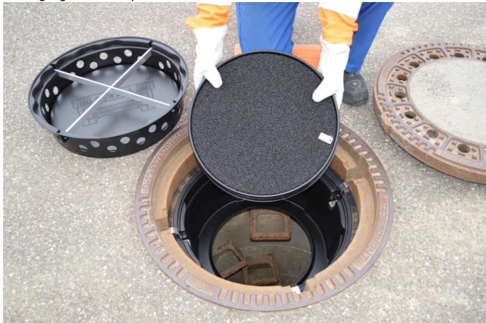
Geringe Niederschläge und Sommerwärme lassen die Abwasserkäne müffeln. Doch mit Straßenkanalfiltern können die Gerüche zurückgehalten werden (Bild: Fritzmeier).
