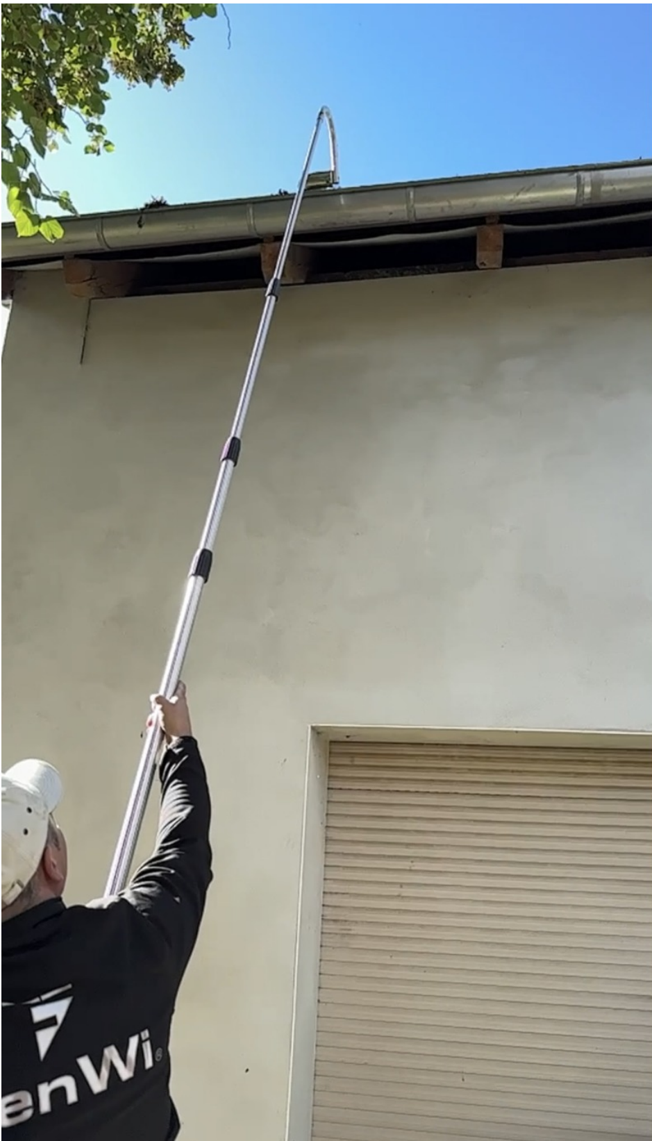
Ohne Leiter hoch hinauf – komfortable Dachrinnenreinigung vom Boden aus (Bild: FenWi).
