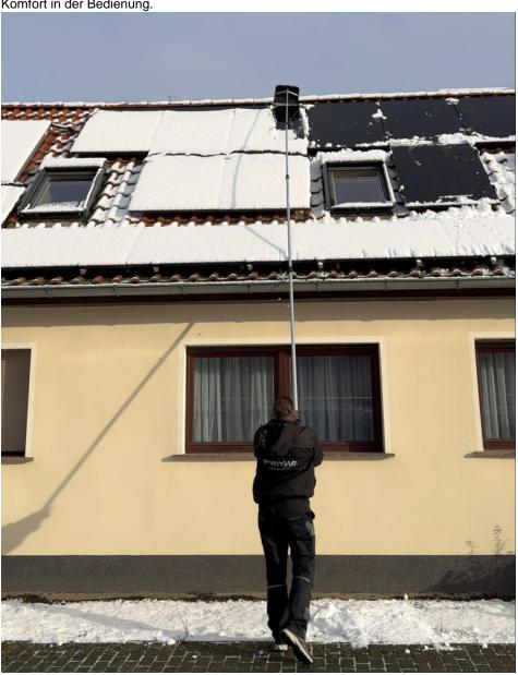
Mit einem Aufsatz aus Kunststoff werden Solarmodule einfach von Schnee befreit (Bild: FenWi).
