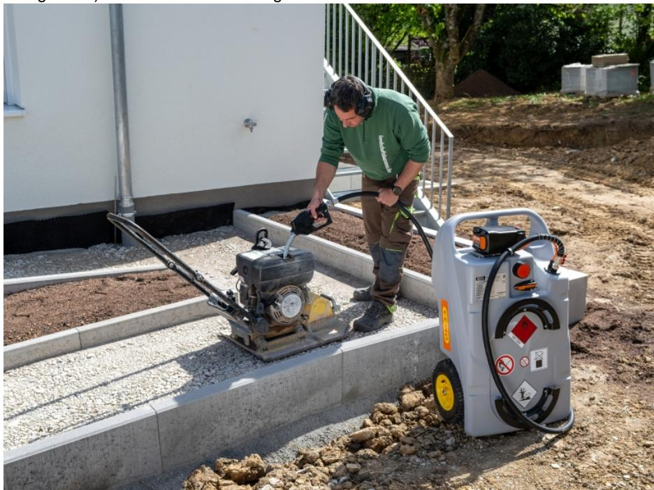
Auch der »APready Trolley« kann mit dem 36-V-Stihl-Akkusystem betrieben werden (Bild: Cemo).
