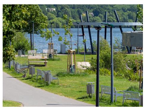
Aufgrund des großen Mastabstandes kam eine Leuchtenausführung mit besonders breit strahlender Optik zum Einsatz (Bild: Schuch).
