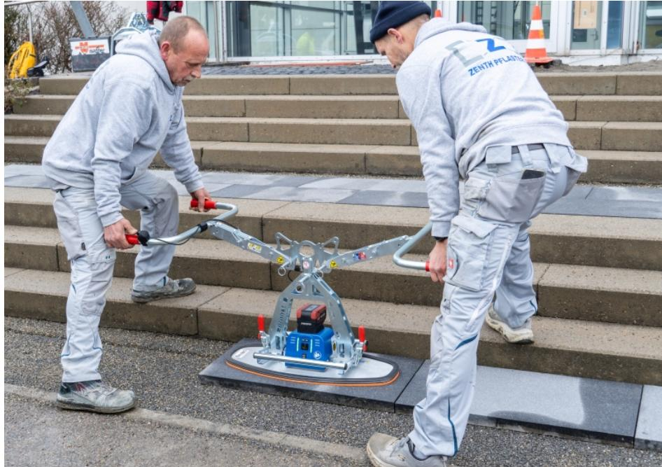
Neues Vakuum-Handverlegegerät im Einsatz auf der Baustelle (Bild: Probst).
