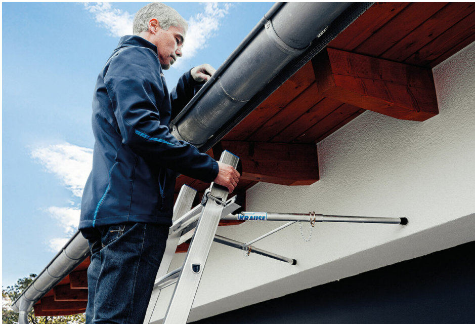
Der Wandabstandhalter von Krause im Einsatz an einer Hauswand. (Bild: KRAUSE)
