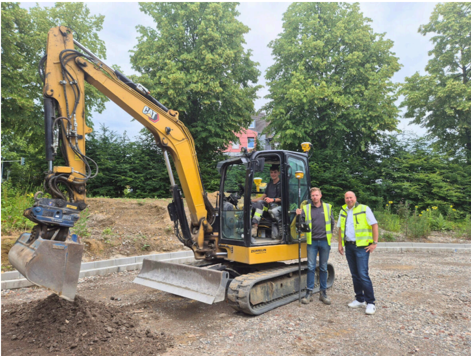
Bild 2: Digitale Steuerung wird auf Kettenbaggern der 15- bis 30-Tonnen-Klasse sowie auf Minibaggern der Sechs- und Acht-Tonnen-Klasse eingesetzt. (Bild: Becka)
