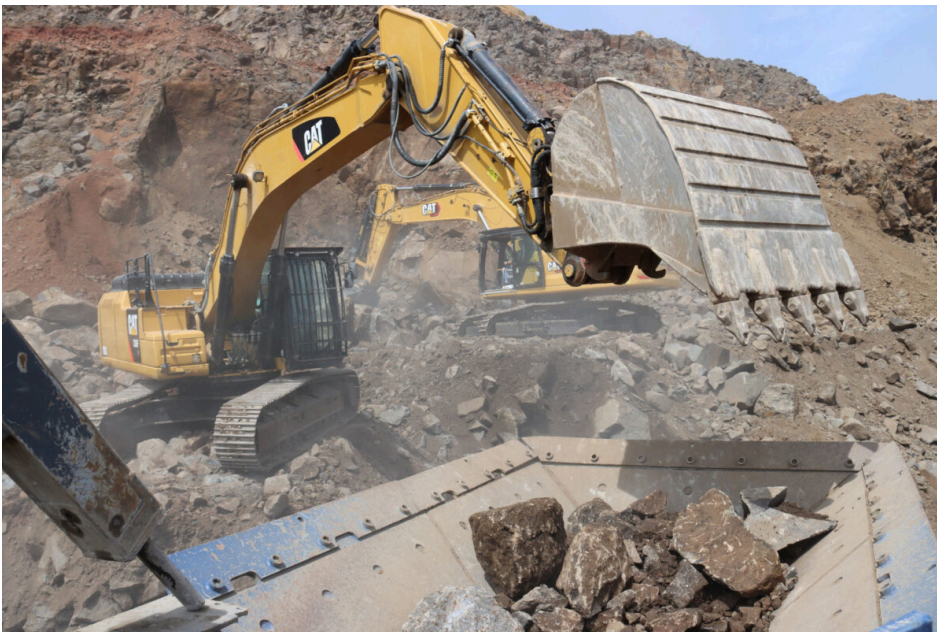
Bild 4: Basalt wird in Burbach gezielt für Frostschutzkörnungen, Schotter, Bruchsteine und Gabionenfüllungen gewonnen; der Maschineneinsatz wurde daran angepasst. (Bild: Zeppelin)
