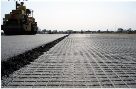
HaTeilt Asphaltbewehrungsgitter von Huesker mit neu aufgebrachter Asphaltdecke.
