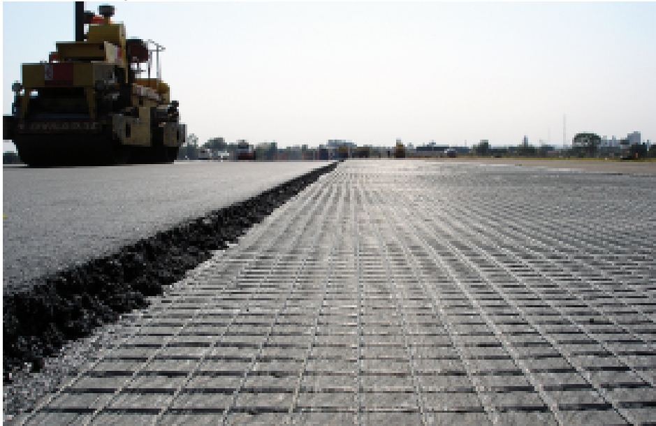
HaTeilt Asphaltbewehrungsgitter von Huesker mit neu aufgebrachtter Asphaltdecke.
