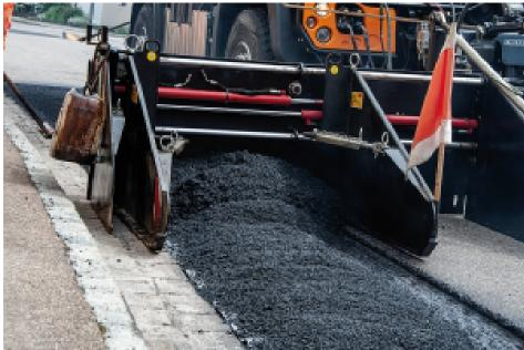
Verschluss eines Kabelgrabens mithilfe des Asphalt-Seitenverteilers von amtc-abt.
