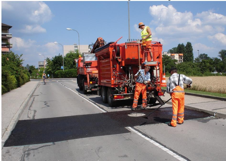
Straßenreparatur mit einem Durchlaufwischer Mini-Mix im manuellen Einbau (schäfer-technik).
