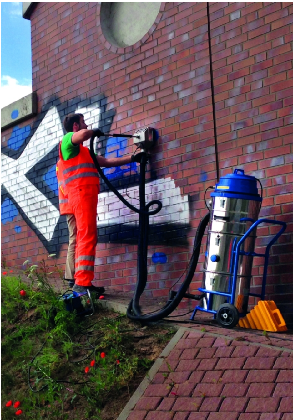
Graffiti-Entfernung mit dem Tornado der Systeco GmbH.
