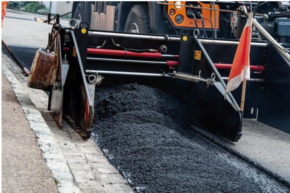
Verschluss eines Kabelgrabens mithilfe eines Seitenverteilers (Bild: amtec-abt).
