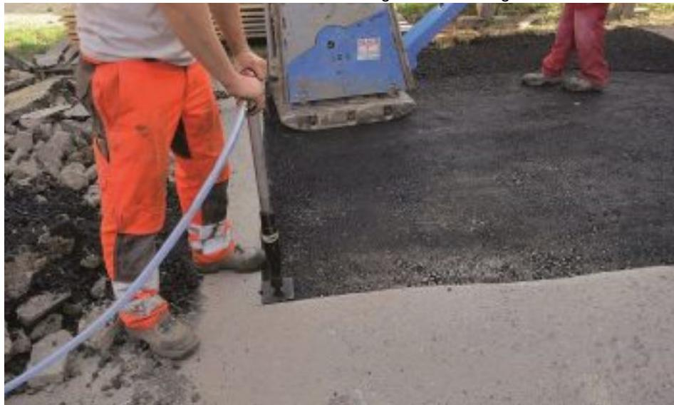
Für die Verdichtung von Kaltasphalt: der Turbo-Digger mit dem neuen S-III-Schlagwerk (Bild: MTM).
