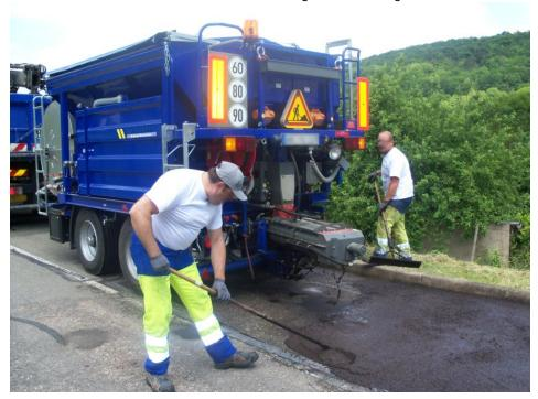
Reparatur einer Straßenoberfläche mit einem Durchlaufmischer »Mini-Mix« im manuellen Einbau (Bild: schäfer-technic).
