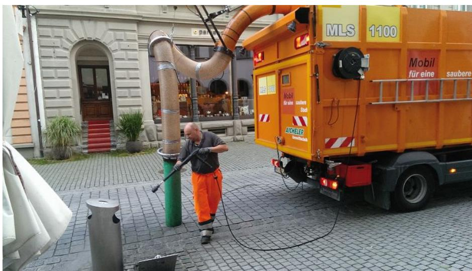
Nach dem Absaugen des unterirdischen Sammelbehälters wird mit der Hochdrucklanze die Einwurfröhre gründlich gereinigt (Bild: Aicheler).
