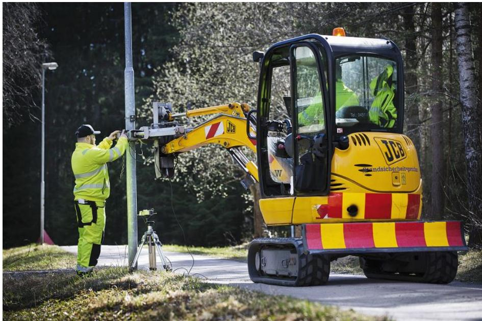
Das Roch-Services-Verfahren bietet eine sichere Standsicherheitsprüfung von stehend verankerten Systemen wie z. B. Ampeln, Laternen und Masten (Bild: Roch Services).
